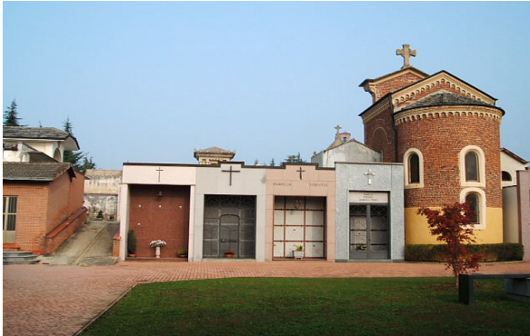
RAMPA OVEST E CAPPELLE
