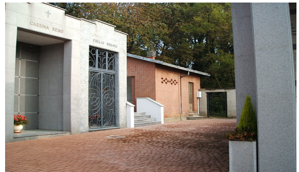
LOCALI DI SERVIZIO
