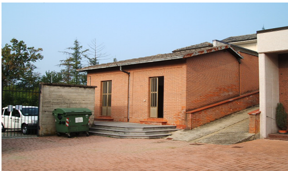
LOCALI DI SERVIZIO
