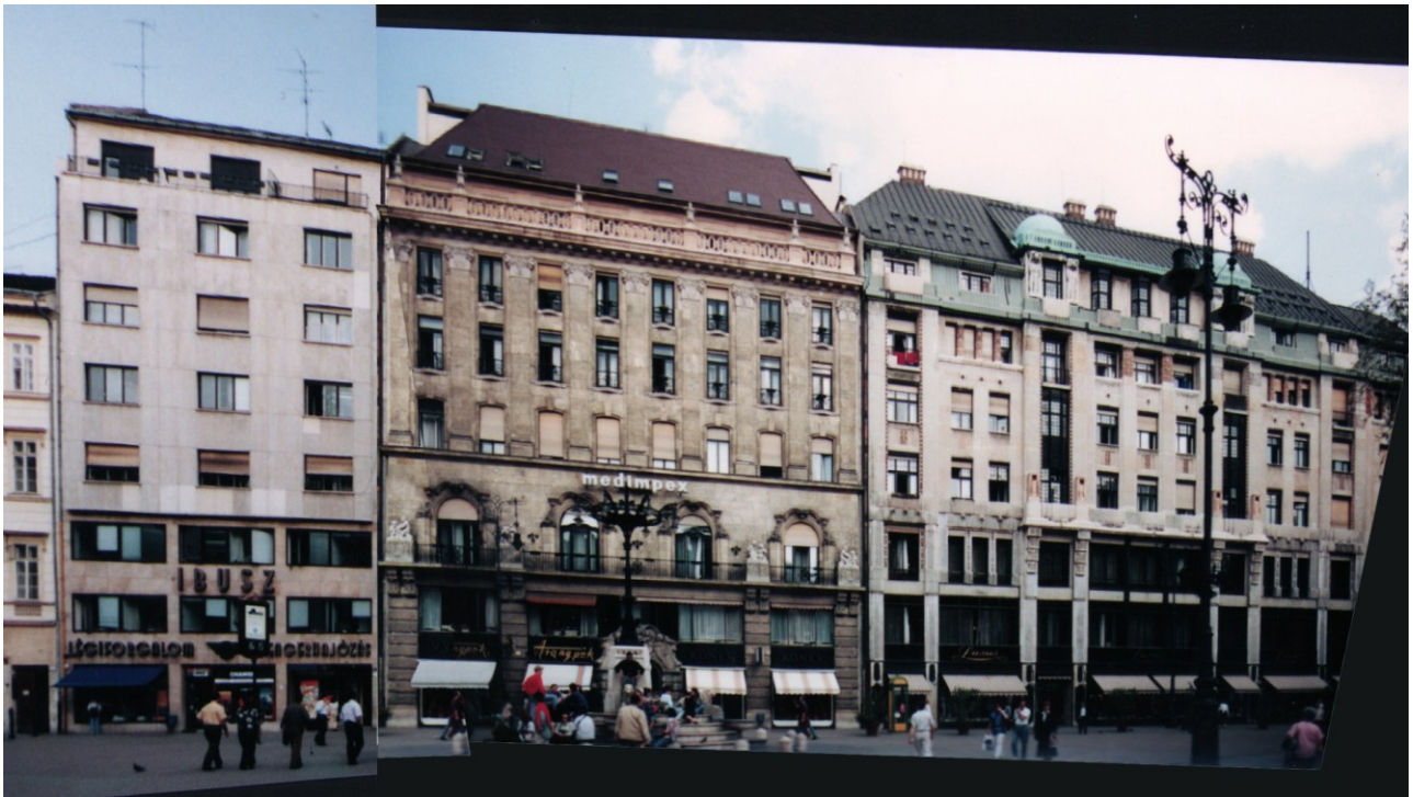
TESSITURA DI FACCIATA (edificio: #2 - ubicazione: Vorosmarty tér)
